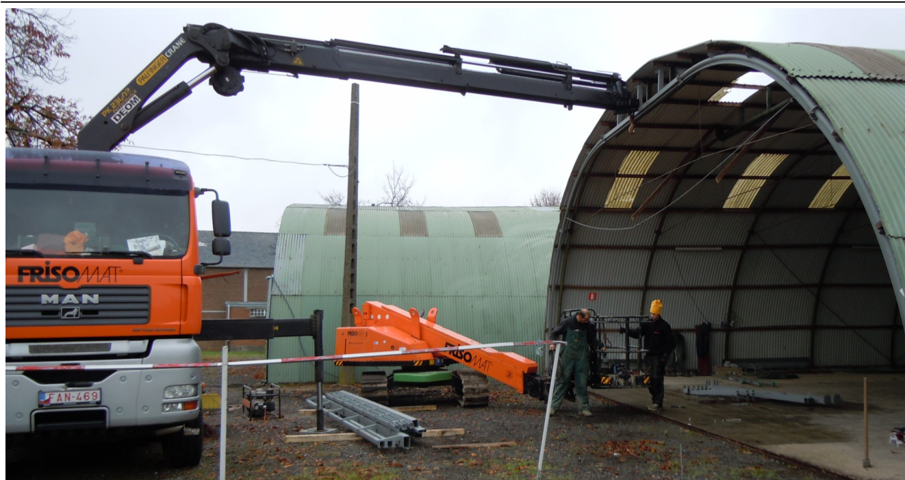
Na de stormschade van vorige zomer, werd aan de loods privé motor, in november, een nieuwe poort geplaatst
